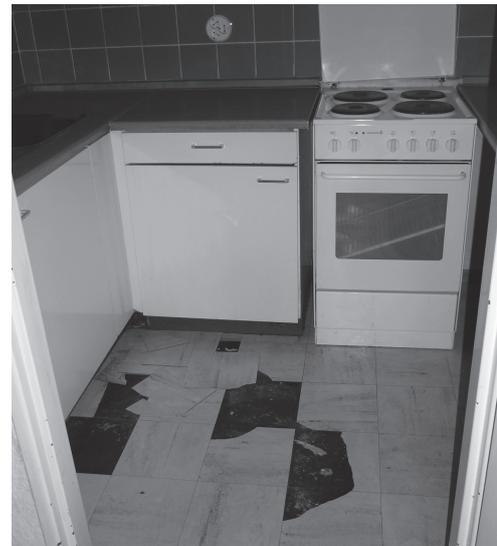
Bild 1. Zustand der asbesthaltigen Flex-Platten vor der Sanierung.
