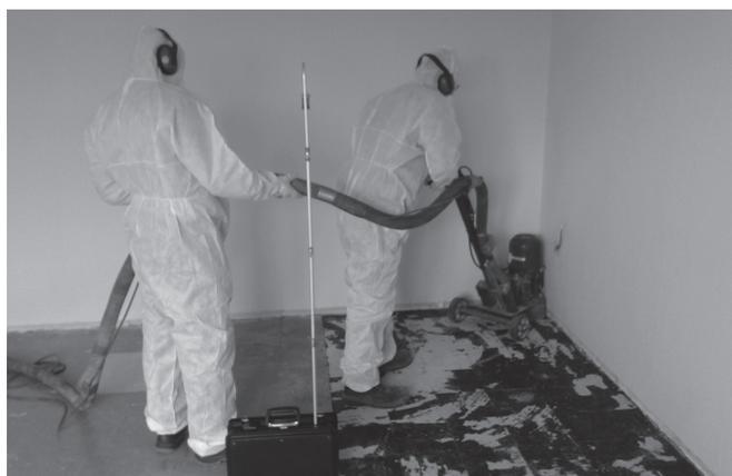
Bild 3. Arbeitsbegleitende Messungen mittels Luftprobenahmegerät vom Typ APC PNA 384 im Sanierungsbereich während des Fräsvorgangs.
