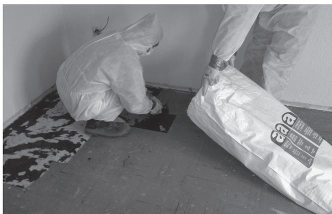
Bild 2. Zerstörungsarmes Entfernen der Flex-Platten aus der Kleberschicht.
