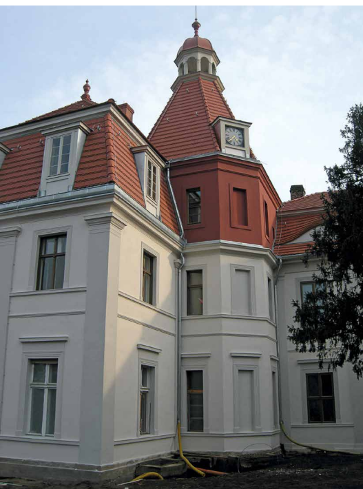
Abb. 14: Der sanierte Turmbau
