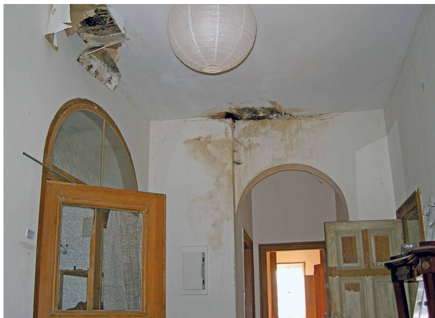
Abb. 3: Wasserschäden
