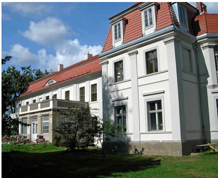
Abb. 15: Der sanierte Kernbau
