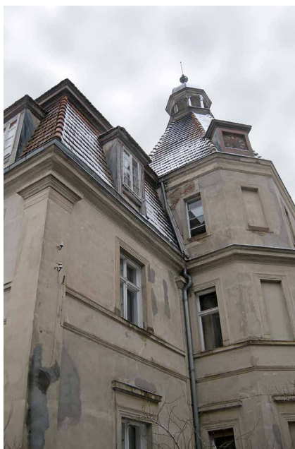
Abb. 2: Der Turmbau vor der Sanierung
