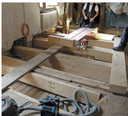
Abb. 12: Sanierung Geschossdecke
