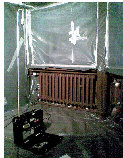
Abb. 4: Asbestsanierung im sowjetischen Arbeitszimmer
