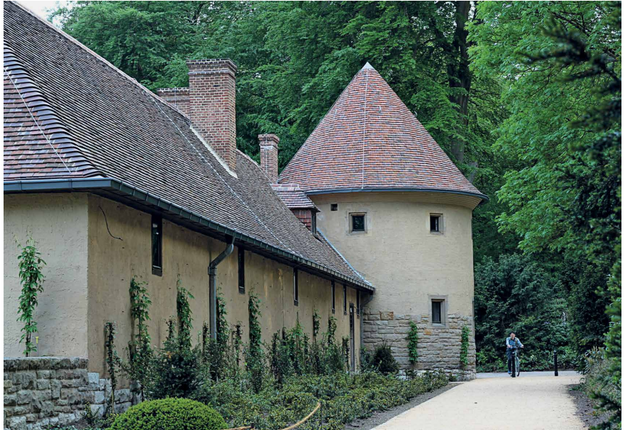
Abb. 16: Gemischte Eindeckung aus 70 % Alt- und 30 % Neuziegeln
