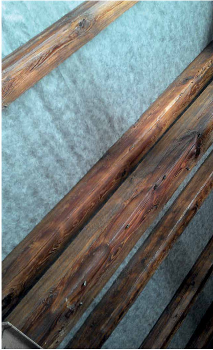
Abb. 15: Zweifach beschichtetes Dachtragwerk
