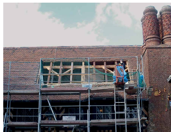
Abb. 10: Dachdeckung der Musterachse
